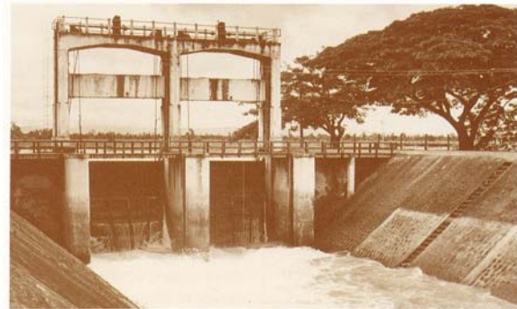
ประตูระบายน้ำ
