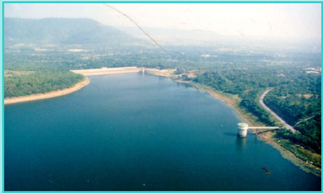
ภาพที่ 8.1 อ่างเก็บน้ำ
