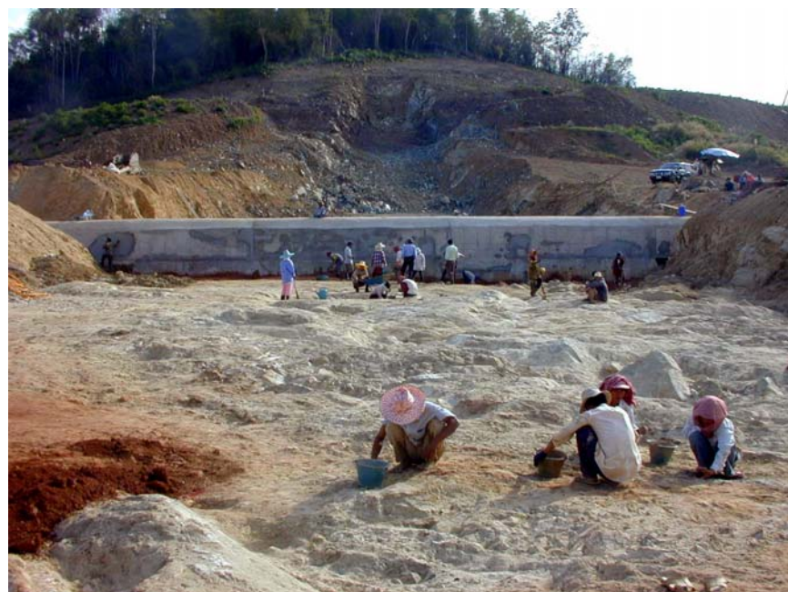
รูปที่ 9-6 แสดงหน้าหินที่ทำความสะอาดแล้ว
