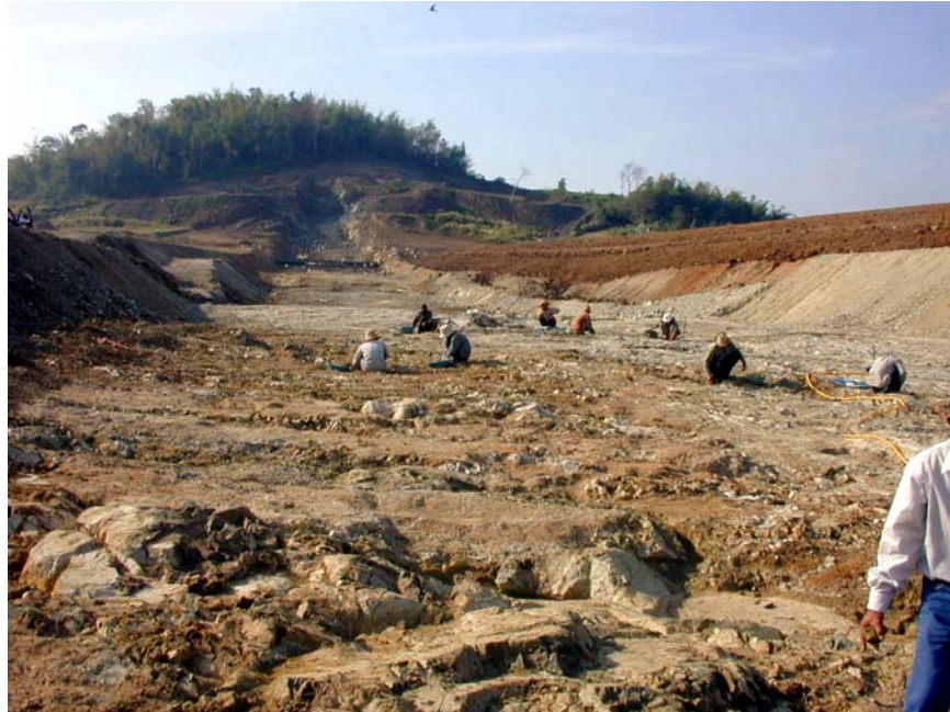
รูปที่ 9-5 แสดงการทำความสะอาดผิวหน้าหิน
