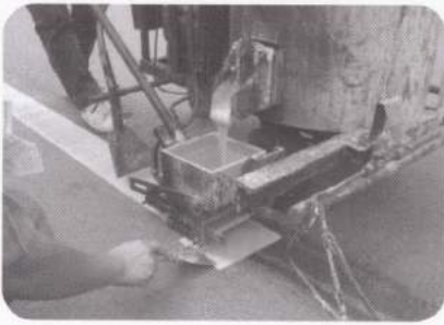
รูปที่ ๓๔ กัดแผ่นเหล็กให้อยู่กับที่ขณะทาสี เมื่อสีแห้งยกแผ่นเหล็กมาตรวจสอบสี ทาสีผ่านแผ่นเหล็กที่วาง
