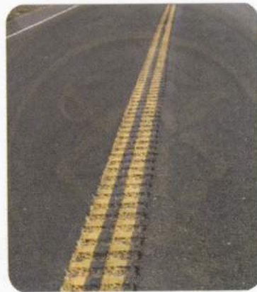
รูปที่ ๒๑ ตัวอย่างการทำแถบชะลอความเร็วบนกึ่งกลางทาง
