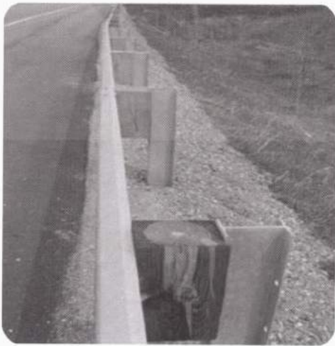
รูปที่ ๖ การติดตั้งราวกันอันตรายแบบรวมเหล็กลูกฟูกบนเสาค้ำข้างทางและเกาะกลาง
