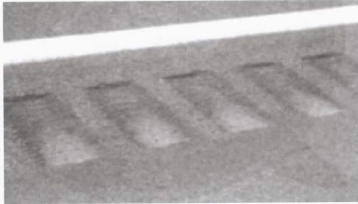
รูปที่ ๒๓ แถบชะลอความเร็วข้างทางแบบเจาะหรือเซาะ (Milled)
