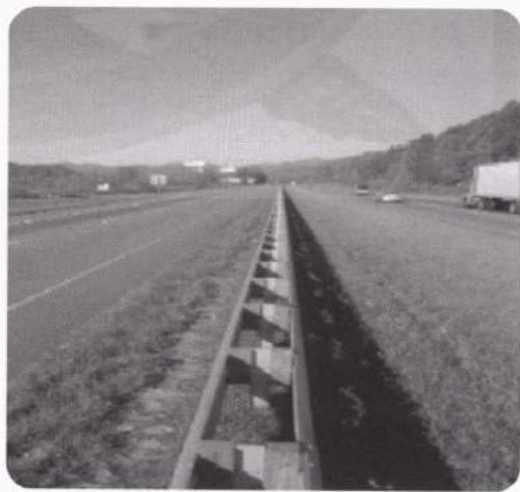
รูปที่ ๖ การติดตั้งราวกันอันตรายแบบรวมเหล็กลูกฟูกบนเสาค้ำข้างทางและเกาะกลาง
