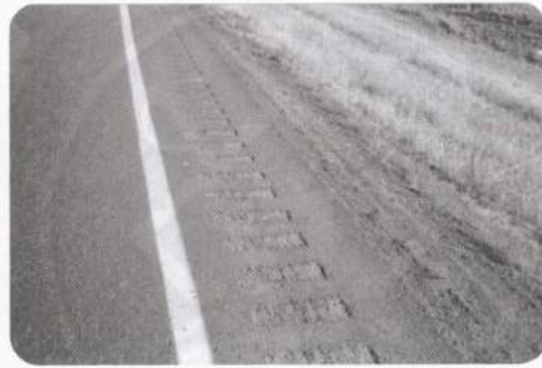
รูปที่ ๒๕ ตัวอย่างการติดตั้งแถบชะลอความเร็วข้างทางที่ระยะไม่เพียงพอ สำหรับรถจักรยาน/จักรยานยนต์
